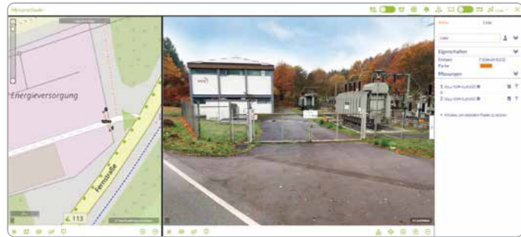
Die Einfahrt zum Umspannwerk Beerwald
